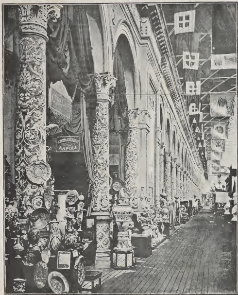
Façade de la Section Italienne
